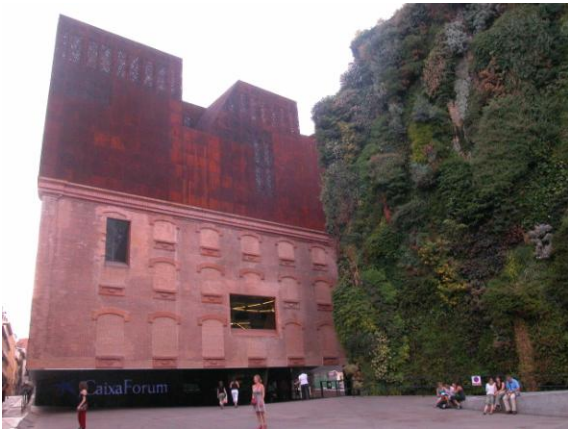
Fig. 2. Caixa Fórum verticalgreen facade, Madrid.
